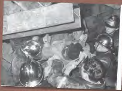
1964 - un ouvrier écrasé par le bâtiment qu'il construisait
